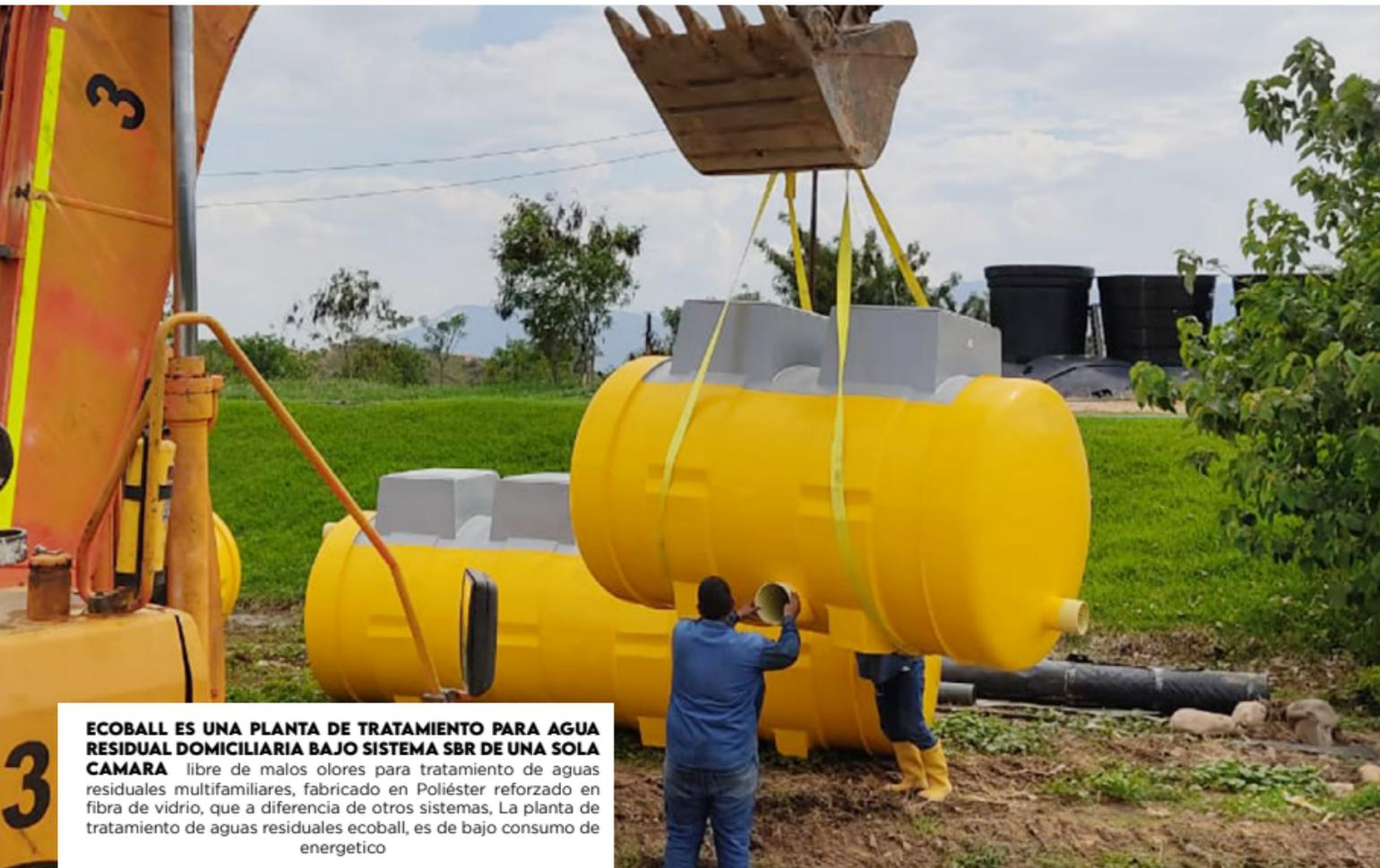
**ECOBALL ES UNA PLANTA DE TRATAMIENTO PARA AGUA RESIDUAL DOMICILIARIA BAJO SISTEMA SBR DE UNA SOLA CAMARA** libre de malos olores para tratamiento de aguas residuales multifamiliares, fabricado en Poliéster reforzado en fibra de vidrio, que a diferencia de otros sistemas, La planta de tratamiento de aguas residuales ecoball, es de bajo consumo de energetico
